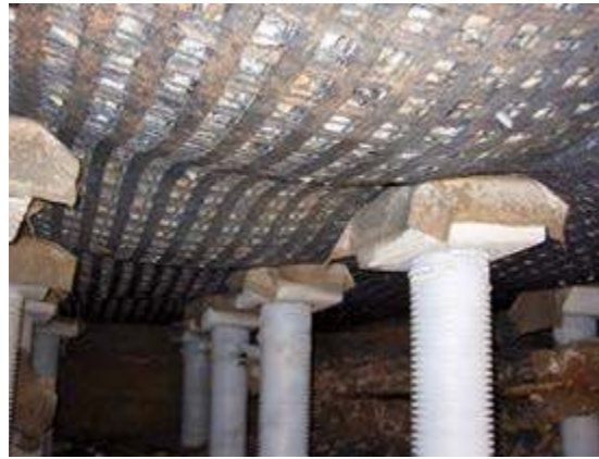
Kalvoefekti paalutetussa penkereessä (Rautatie Bidor-Rawang, Malesia)
