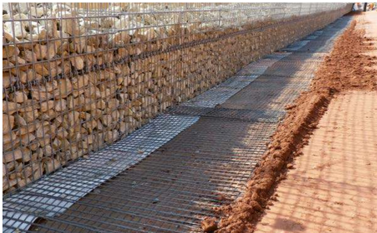
Kivikorimuurin lujittaminen (A3 moottoritie lähellä Haseltalia, Saksa)
