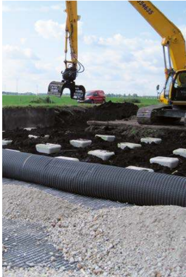
Geotekstiililujitte asennettuna paalujen päälle (N 210; Alankomaat)
