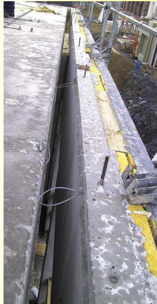
PASI-lenkki kiinnitetään tuoreeseen valuun tehtaalla.
