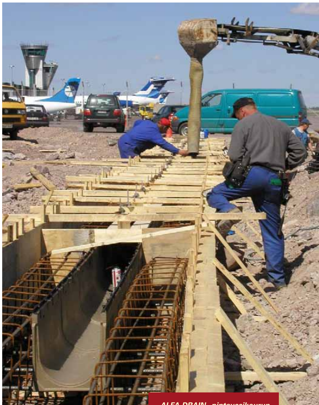
ALFA-DRAIN –pintavesikourun asennusta Helsinki-Vantaan lentoaseman asematason laajennustyön yhteydessä.
