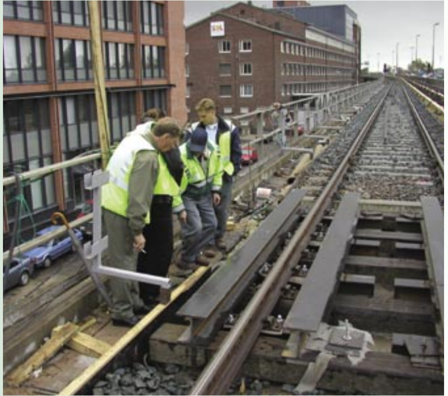
Liikuntasaumalaitteen asennusta Junatien siltaan Herttoniemen metroaseman tuntumassa.
