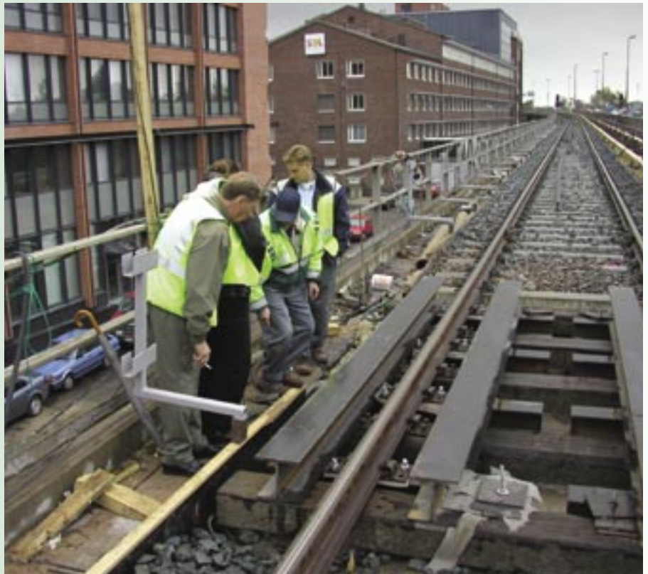
Liikuntasaumalaitteen asennusta Junatien siltaan Herttoniemen metroaseman tuntumassa.
