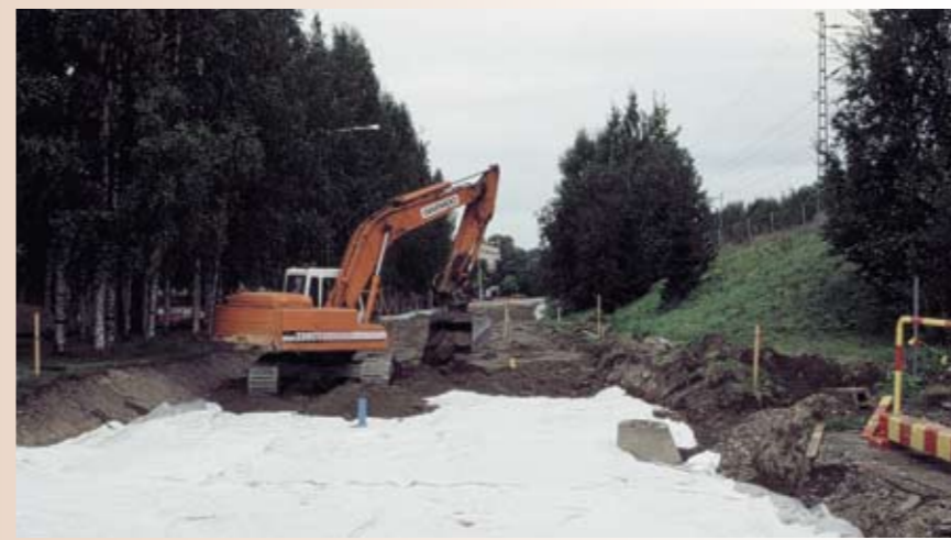
Parivaljakonttiellä Helsingissä tutkittiin sivutuoterakenteita. Yhdessä rakenteessa käytettiin Comtrac-lujitekangasta rengasrouheen päällä.
