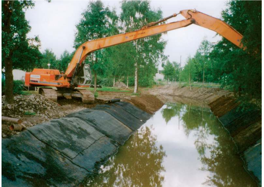
Helsingin Myllypuron puisto-oja sai kestäväen eroosiosuojan Enkamat A:n avulla.
