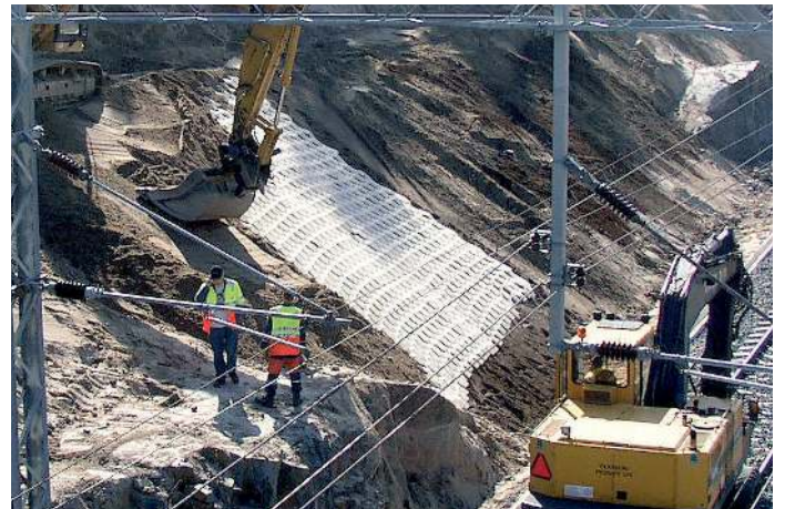
Armater asennettuna jyrkkään luiskaan Hyvinkään ratapihalla.
