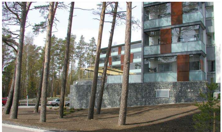
Vuosaaren taiteilijatalossa kivikoreja on käytetty julkisivuverhouksissa ja pihan pengerrakenteissa.
